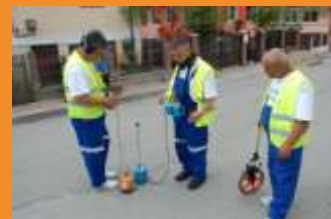
Tehnologii utilizate pentru prelocalizarea pierderilor de apă : teledetecția, georadarul, debitmetrie, loggeri de zgomot.
