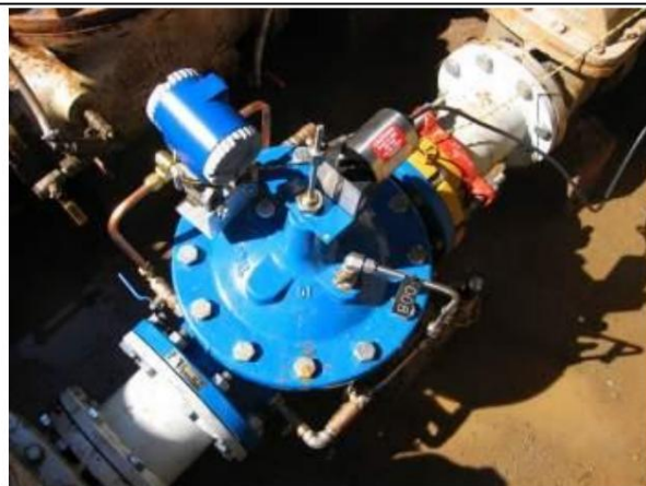
Imaginea 2: Măsurarea PRV pe bypass.
