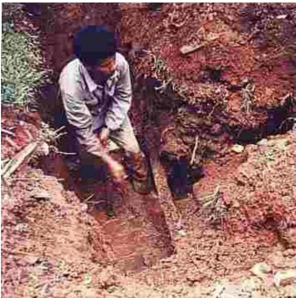
Figura E-2 Excavare manuală.
