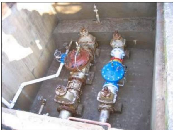
Imaginea 1: Stație de reglare a presiunii.
