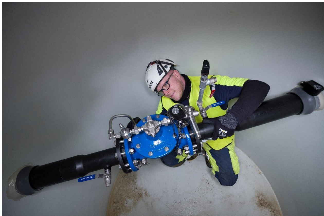
Instalarea unei camere de admisie DMA nou-nouțe cu PRV
