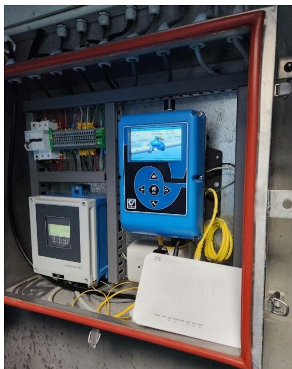
Modulul de telemetrie și control al Stației DMA de Control al Presiunii și Contoare, Columbia
