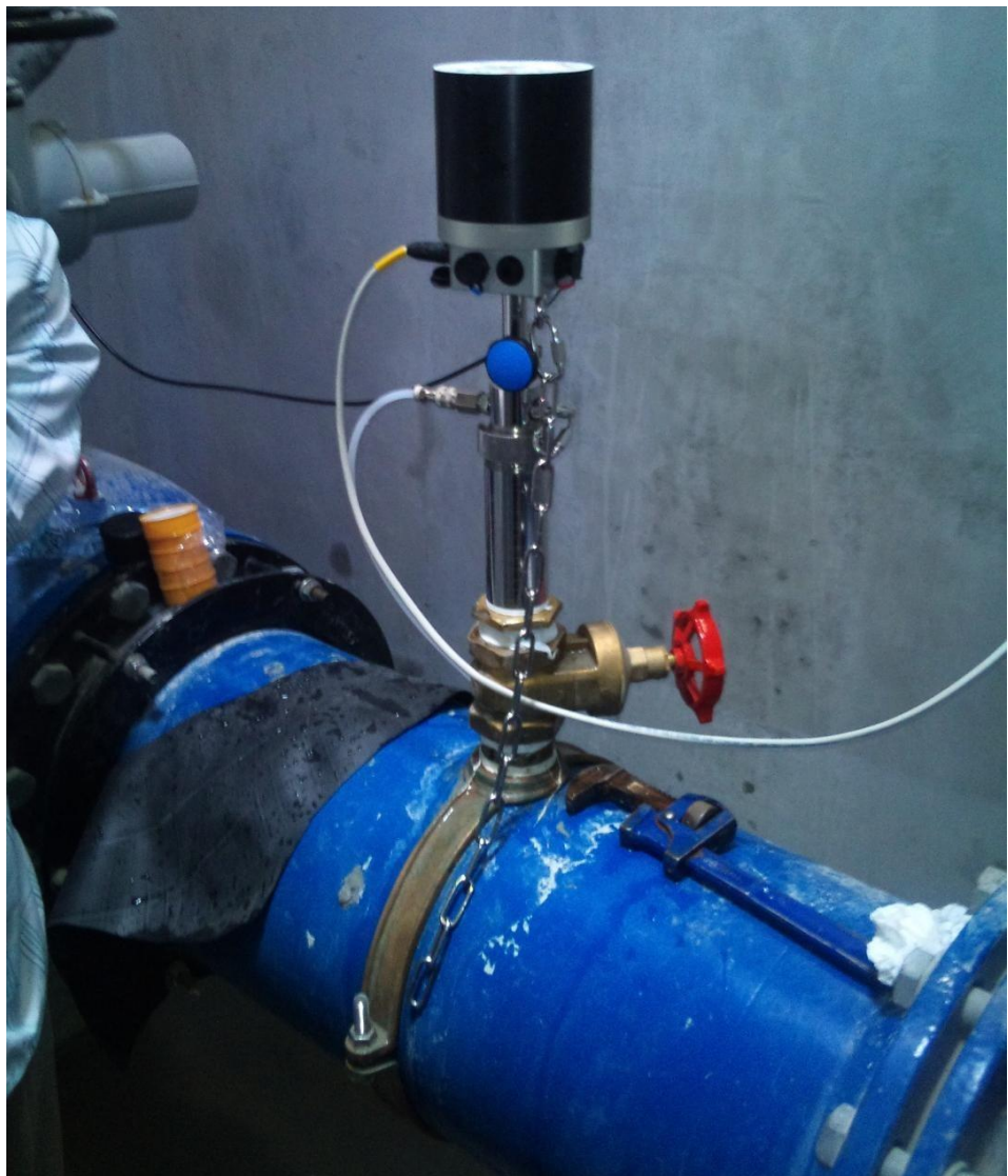
Camera de Admisie DMA în EAU cu monitorizare suplimentară a calității apei și Comunicare online de date
